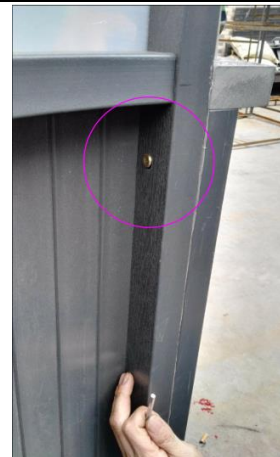
10. Fixez-les avec des vis 4PCS 16 # M8 * 68mm.
