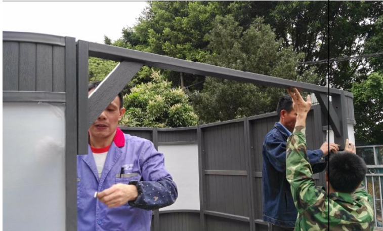
7. Fixez-les avec des vis 2PCS 16 # M8 * 68mm.
