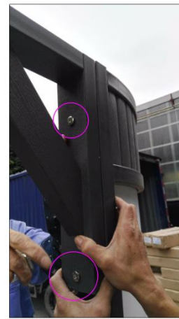
8. Fixez-les avec des vis 2PCS 16 # M8 * 68mm.
